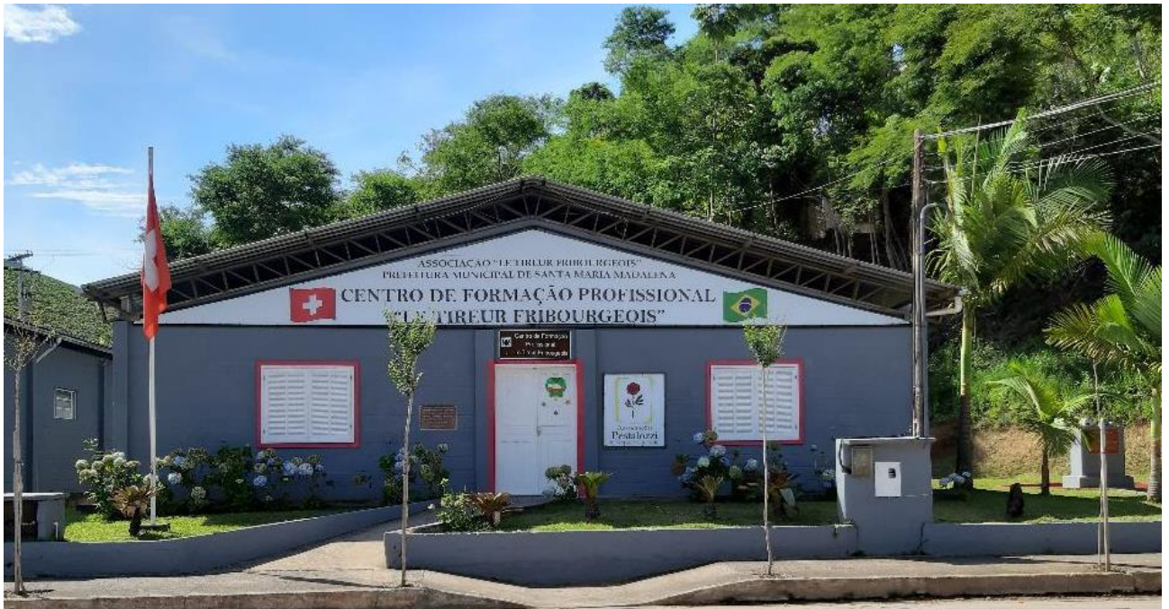
Tous nos bâtiments sont ainsi rénovés et remis à neufs, autant à l'extérieur qu'à l'intérieur.
